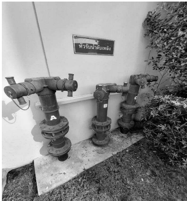
รูปที่ 2.6-1 ห้รดับน้ำดับเพลิงภายนอกอาคาร
