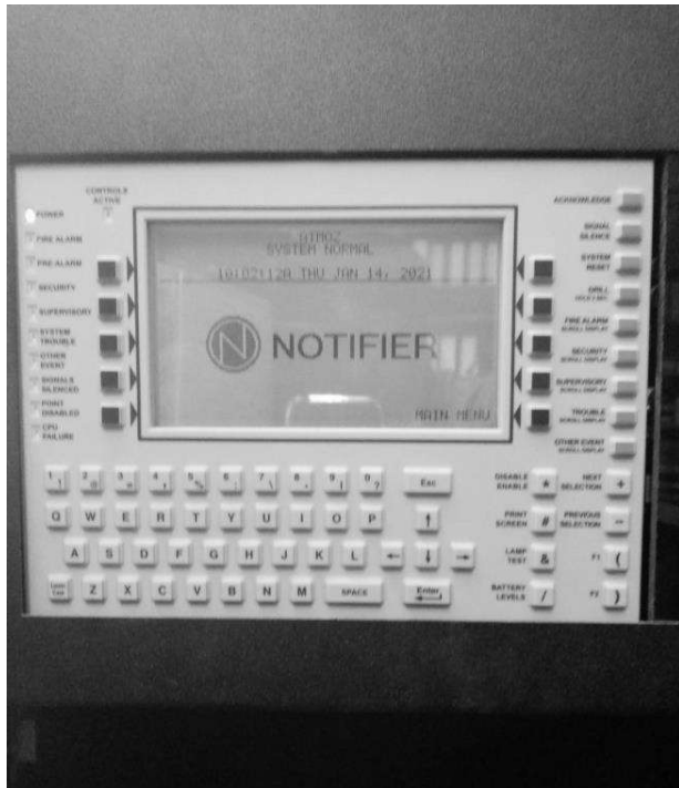
รูปที่ 2.7.2-1 แผงควบคุม (FCP)
