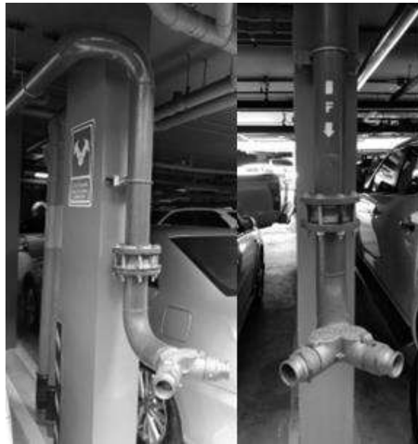
รูปที่ 2.7-2 ห้รดับน้ำดับเพลิงภายในอาคาร
